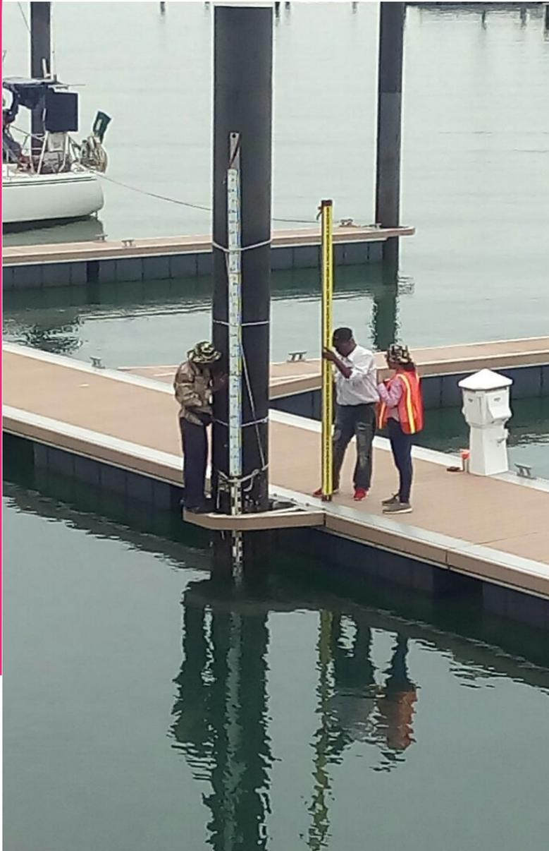
Se realizan monitoreos de mareas en el pacífico con el objeto de determinar las elevaciones de los planos horizontales de nivel medio de baja marea, nivel medio de alta marea PLEAMAR o deducción del nivel medio del mar o cota cero requerido para la Cartografía, en proyectos de ingeniería como muelles, marinas, desarrollos turísticos en las áreas costeras e insulares
