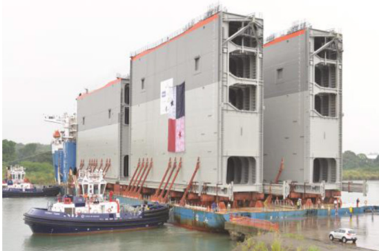
Fig. 2: Llegada de las 4 últimas compuertas
