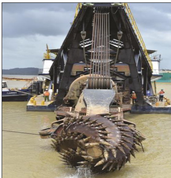
Fig. 4: Draga Hidráulica Míndi, mientras trabaja en el área de Gatún
